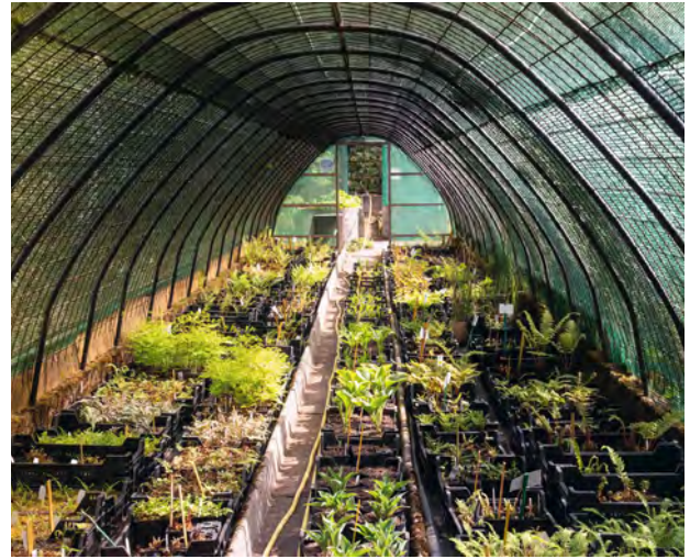
Abb. 2: Einzigartige Schattentunnel – sanft saniert.
